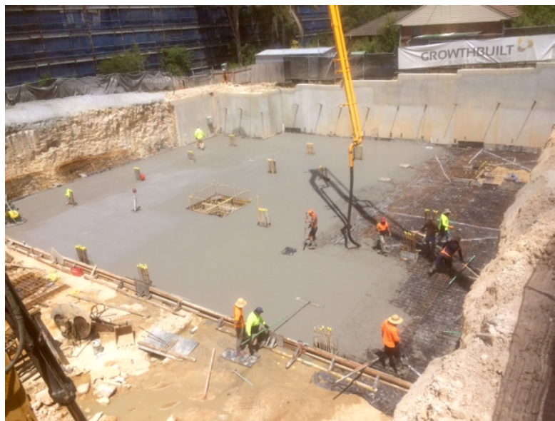
Photo 2: Pour almost complete.
